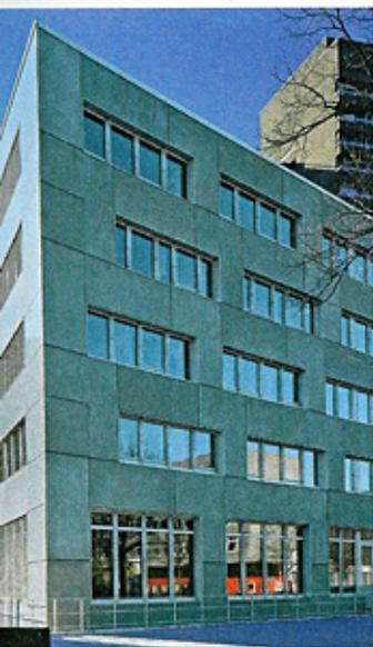
**Fassadengestaltung:** Bekleidung der Fassade mit grünen Betonwerksteinplatten für das Zentrum für Marine und atmosphärische Wissenschaften, Hamburg, von MRLV Architekten Markovic Ronai Lütjen Voß, Hamburg
